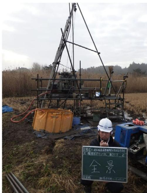
図-3.1.2 機械ボーリング足場仮設概念図
