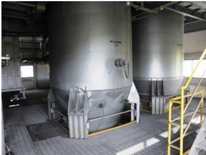
写真番号：内プー 3 5 灰固化化室 4 階 (1FL+13. 0m)
