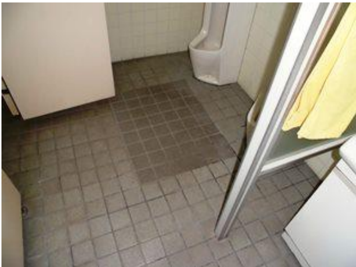
写真番号：内管－１２ １階男子便所
