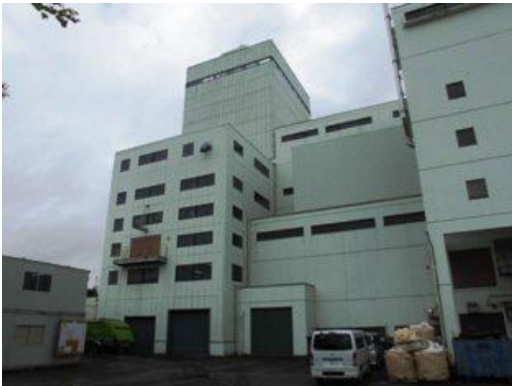
建物外観（北面）
