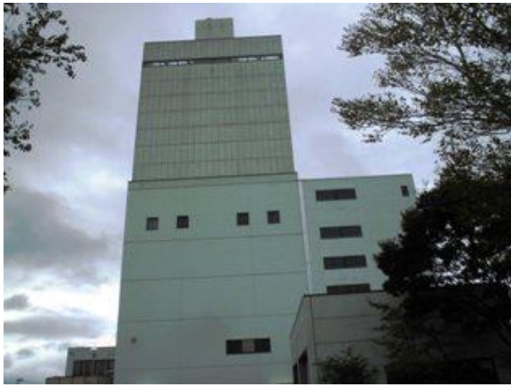
建物外観（東面）
