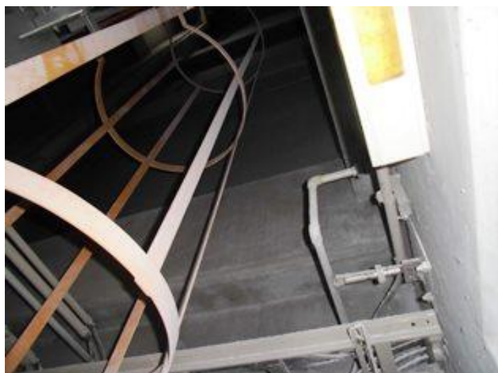
写真番号：内プー 2 1 2 階消石灰サイロ室
