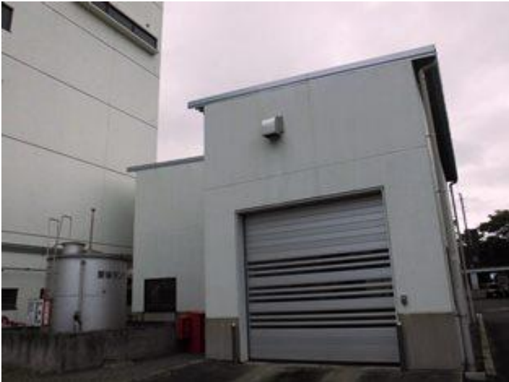
写真番号：付－ 2 助燃剤受入棟 外観
