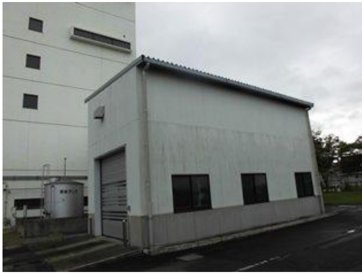
写真番号：付－ 1 助燃剤受入棟 外観
