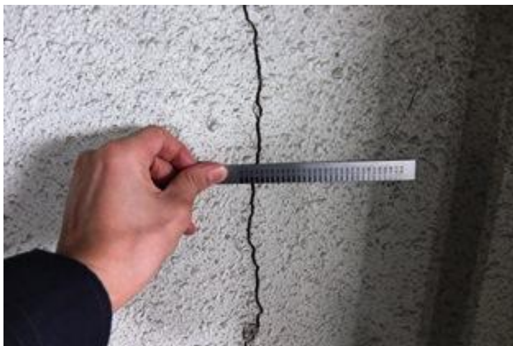
写真番号：内プー 3 3 灰固化化室 3 階 (1FL+10.3m)
