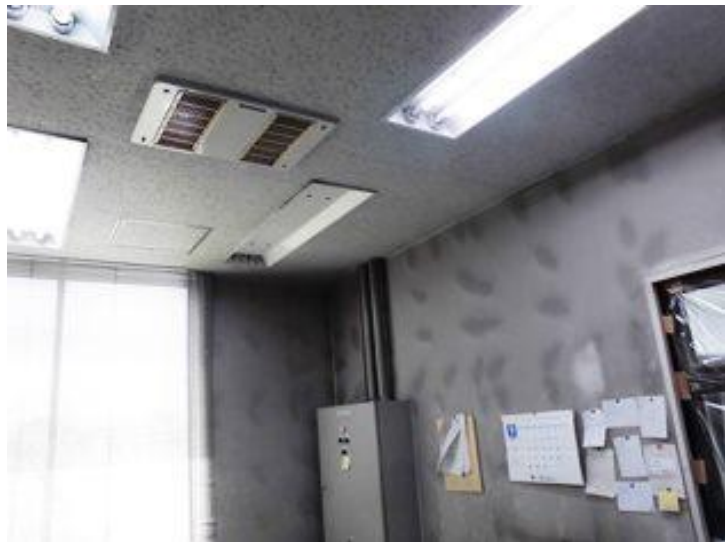
写真番号：内管－ 5 1 階計量室
