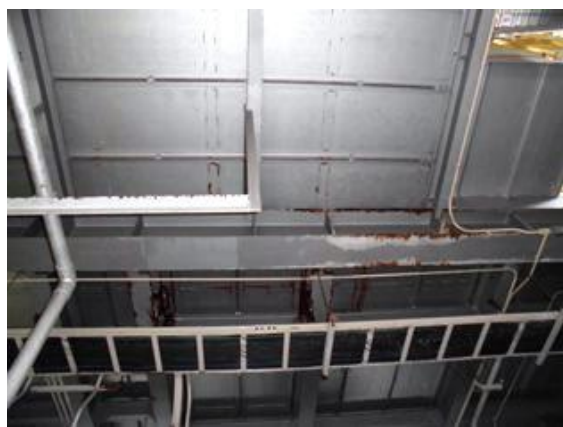
灰固化化室2F床 内ブ-29
