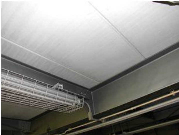
写真番号：内プー 3 6 灰固化化室屋根
