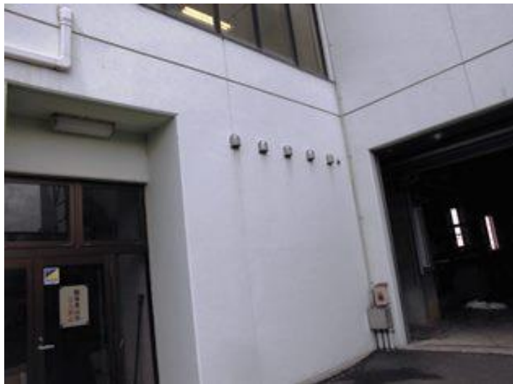
写真番号：外－２８ 東面(職員用玄関部)
