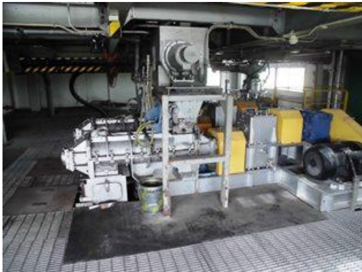
写真番号：内プー 3 1 灰固化化室 3 階 (1FL+7.95m)
