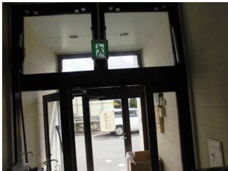
写真番号：内管－１６ １階職員用玄関
