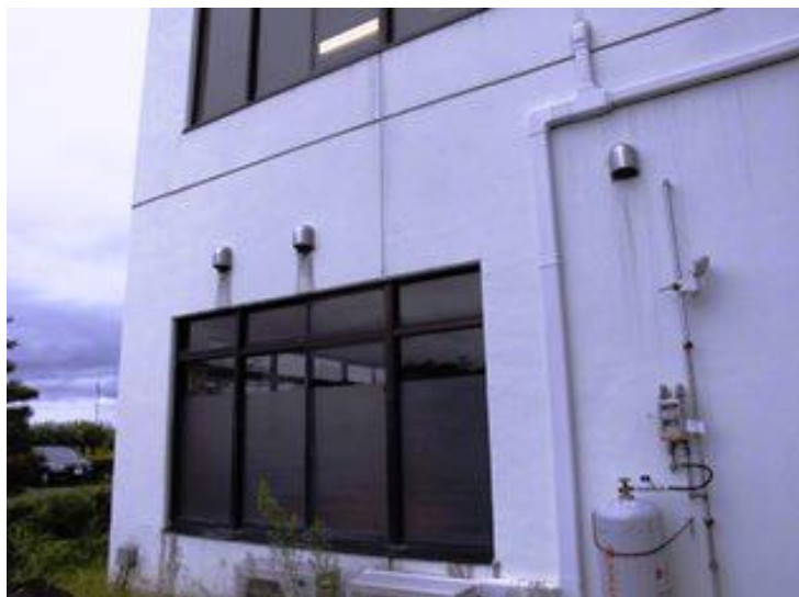
写真番号：外－２９ 東面(浴室外側)
