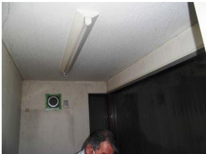
写真番号：内プー 1 9 2 階灰ピットクレーン 操作室
