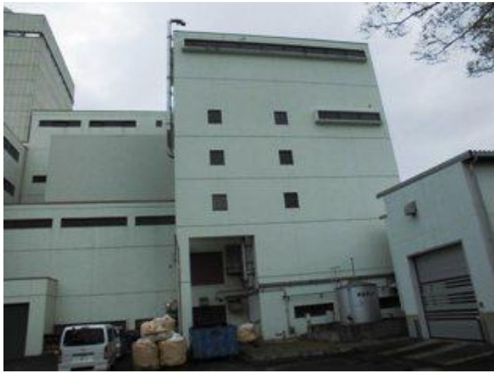
建物外観（北面）
