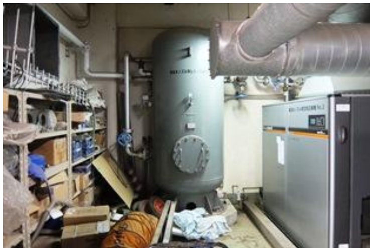
写真番号：内プー 1 6 1 階倉庫
