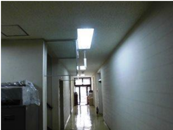
写真番号：内管－１１ １階廊下
