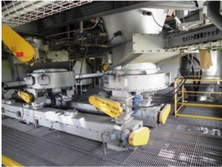
写真番号：内プー 3 4 灰固化化室M 3 階 (1FL+10. 3m)
