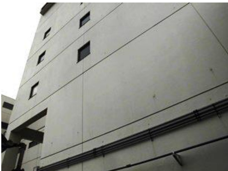
写真番号：外－１７ 北面(防臭室外側)
