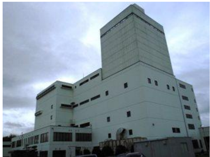
建物外観（南東面）
