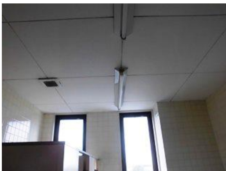
写真番号：内管－２７ ２階男子便所
