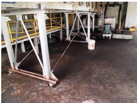
灰固化化室2F床 内ブ-30
