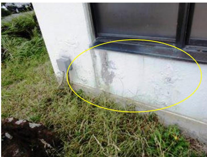
写真番号：外－３０ 東面(浴室外側)
