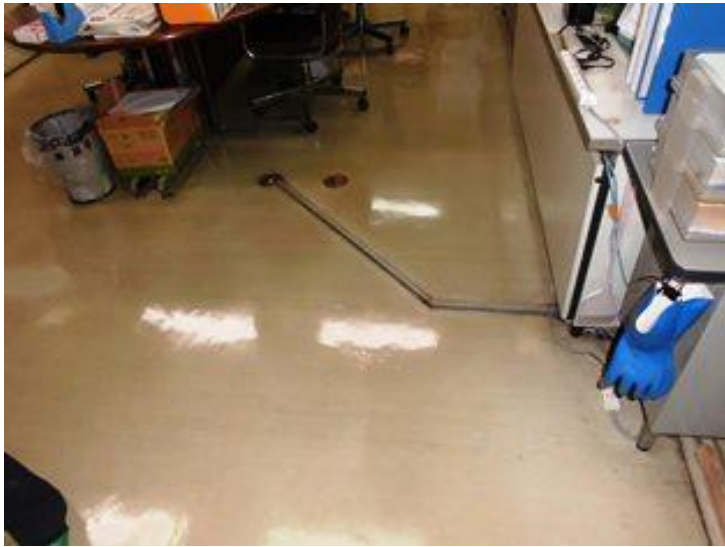
写真番号：内管－ 4 1 階事務室
