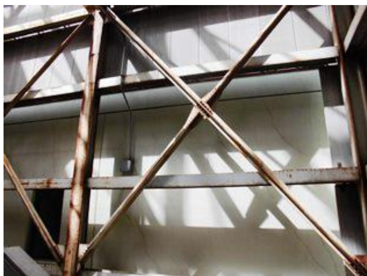
写真番号：外－３１ 東面(炉室屋上部)
