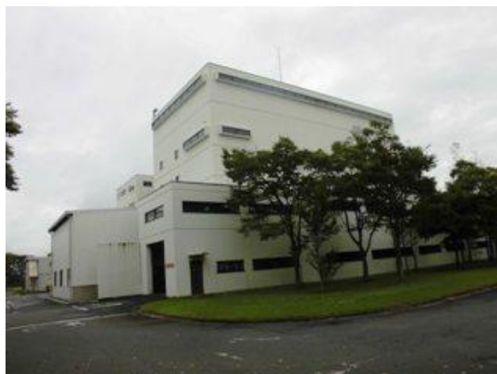
建物外観（北西面）
