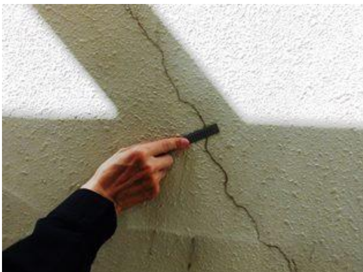
写真番号：外－３２ 東面(炉室屋上部)
