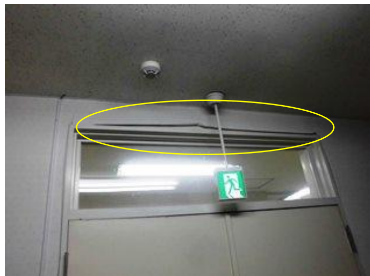
写真番号：内管－ 6 1 階更衣室
