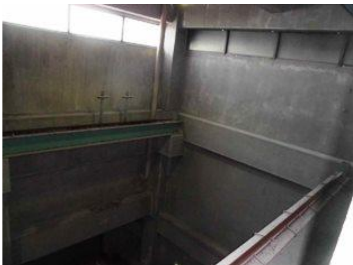
写真番号：内プー 2 0 3 階灰ピット上部
