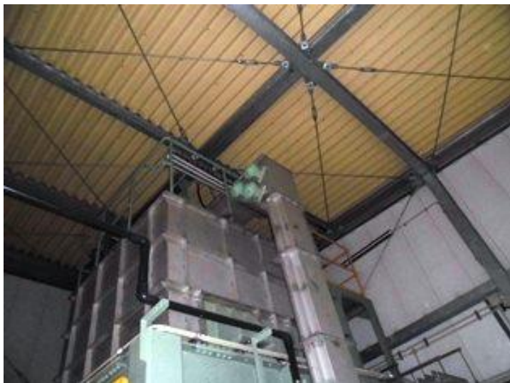
写真番号：付－４ 助燃剤受入棟 屋根部
