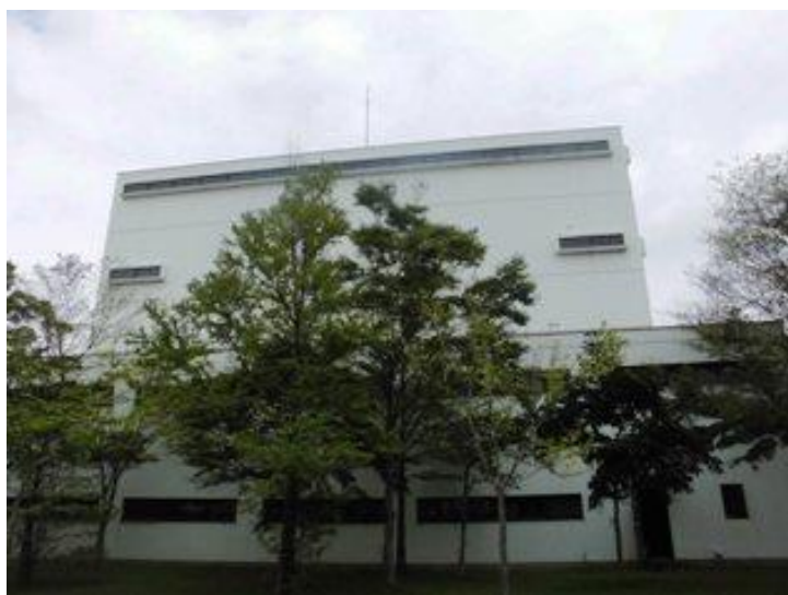
建物外観（西面）
