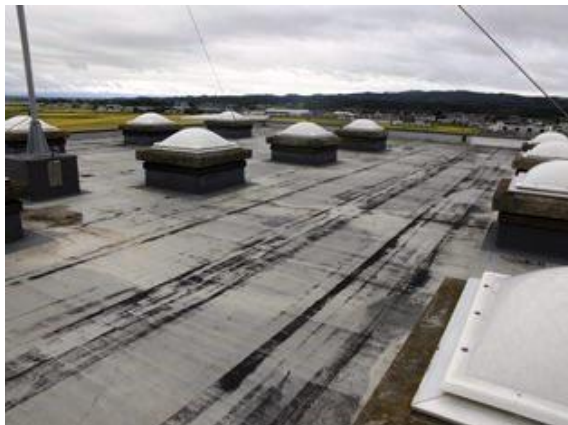
ごみピット上部 屋-1
