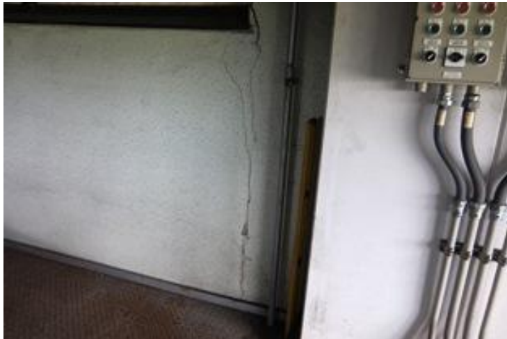
写真番号：内プー 3 2 灰固化化室 3 階 (1FL+10.3m)
